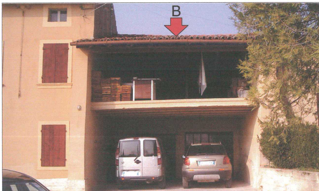
Edificio B - Destinazione d'uso attuale: annesso rustico
