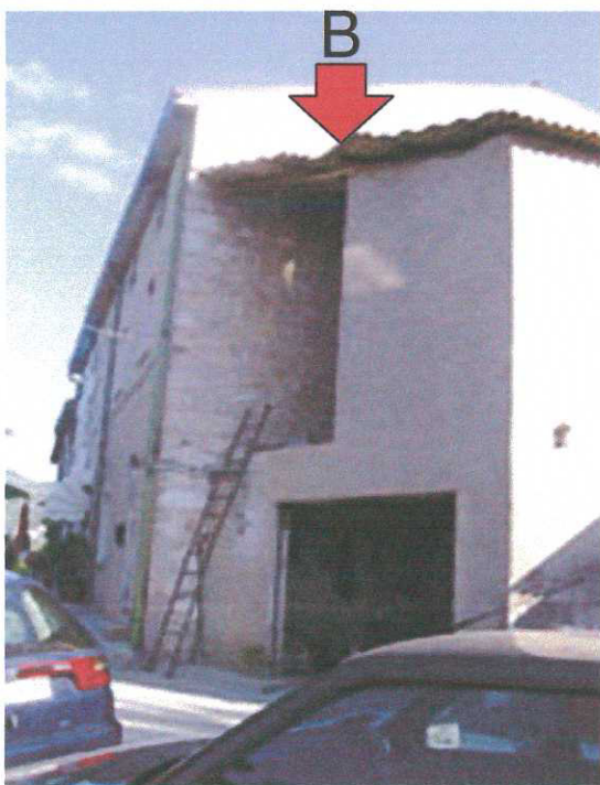
Edificio B – Destinazione d'uso attuale: annesso rustico
