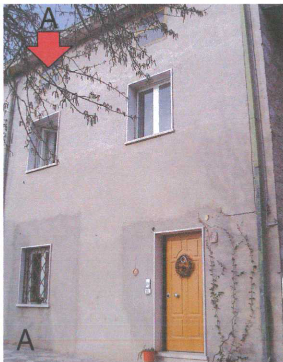
Edificio A: Destinazione d'uso attuale: residenza
