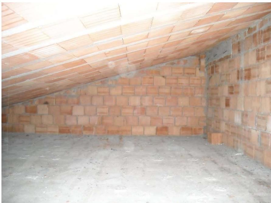
*Sottotetto accessibile mediante botola. Solaio piano di soffittatura in laterocemento sp. 20 cm senza cappa con travetti prefabbricati posti ad interasse 55 cm. Solaio inclinato*
