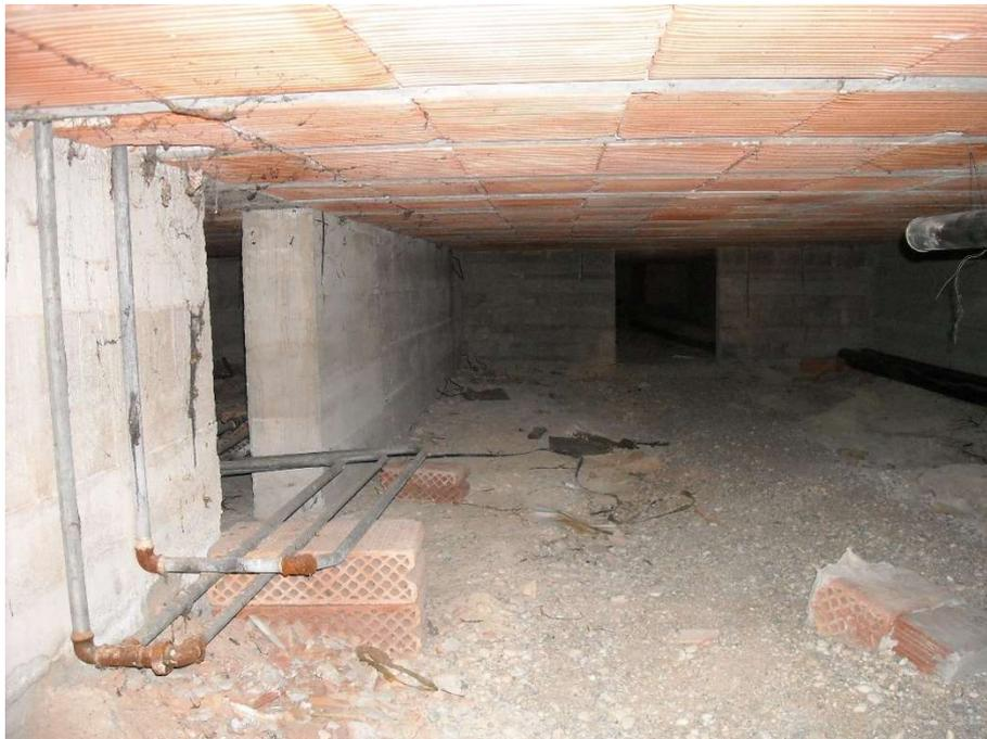
*Fondazioni a travi rovesce in c.a. e solaio di calpestio in laterocemento sp. 20+4 cm con travetti prefabbricati posti ad interasse 55 cm. Zona accessibile mediante botola.*
