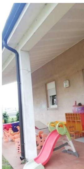
*Telaio in c.a. a sostegno della gronda in laterocemento presente nella zona porticato.*
