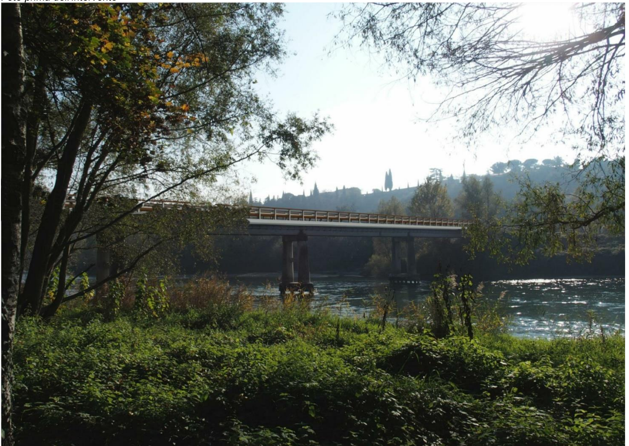
Foto dopo l'intervento
