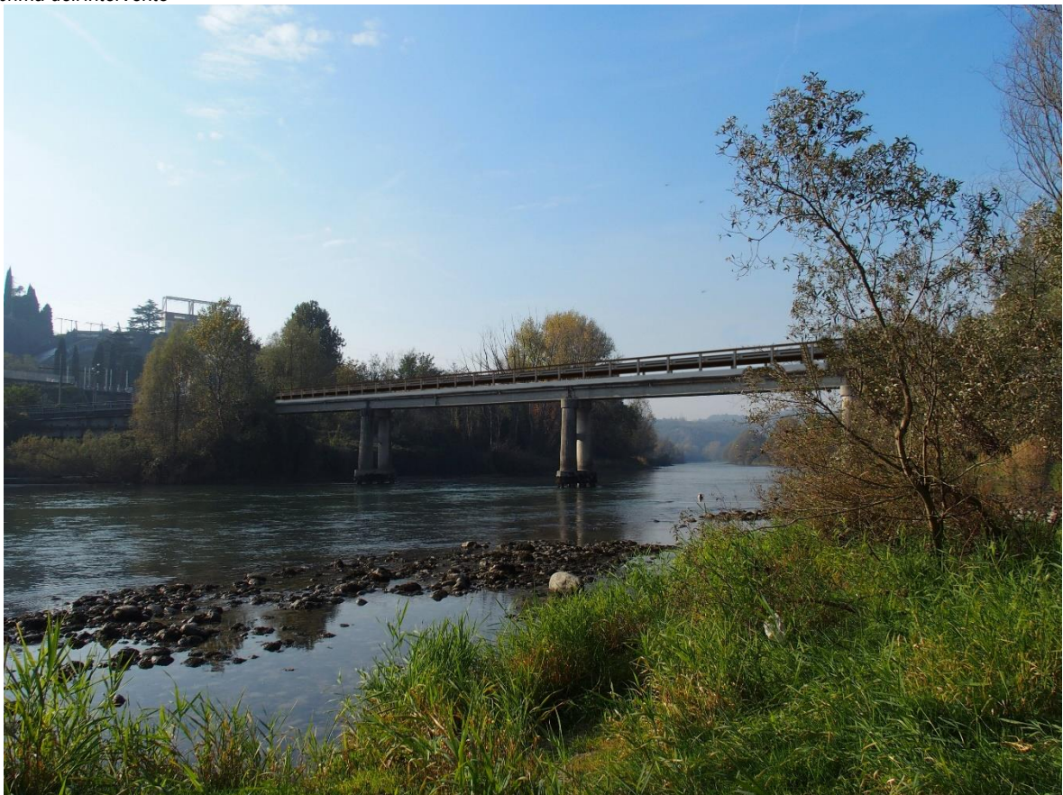
Foto dopo l'intervento
