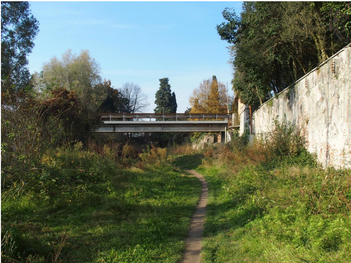
Foto dopo l'intervento
