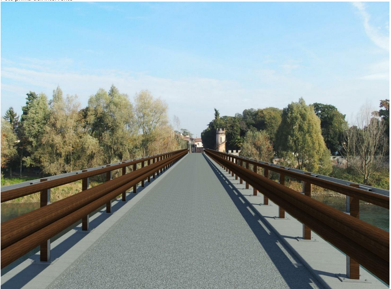
Foto dopo l'intervento
