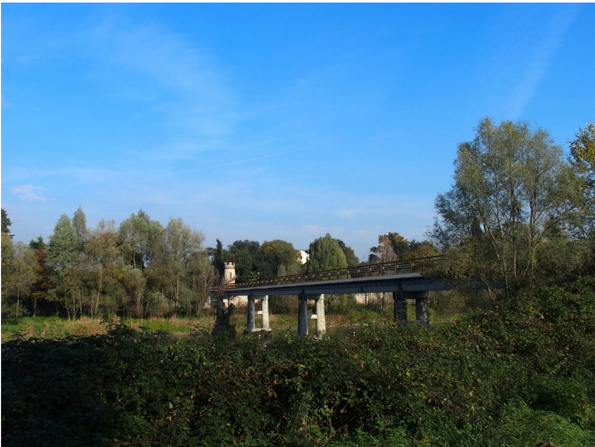
Foto dopo l'intervento
