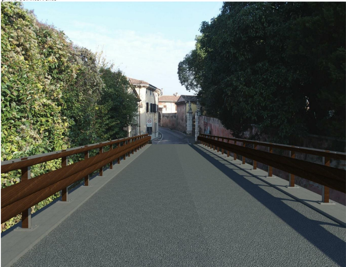
Foto dopo l'intervento
