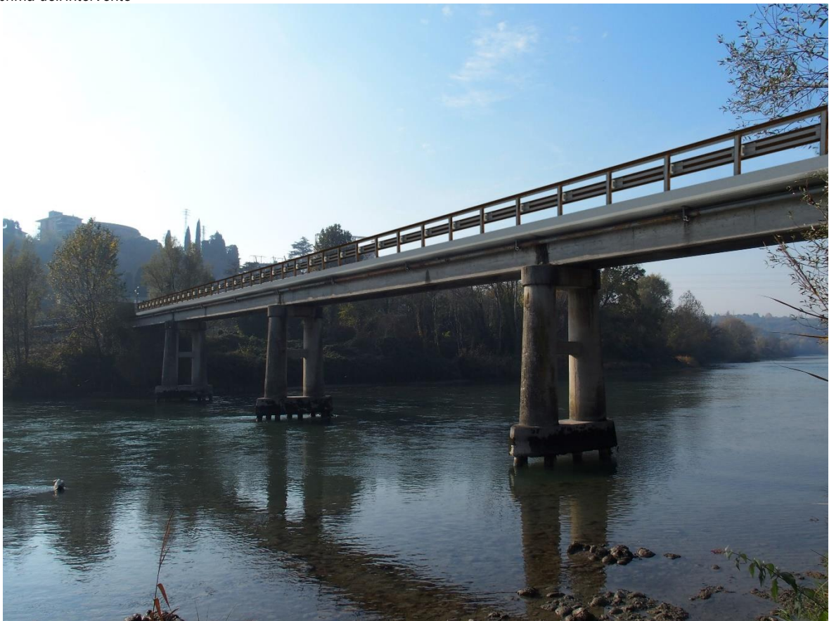
Foto dopo l'intervento
