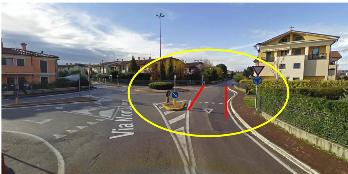
Figura 43 - Dettaglio dell'immissione da via Monti Lessini che non presenta un'adeguata deflessione
