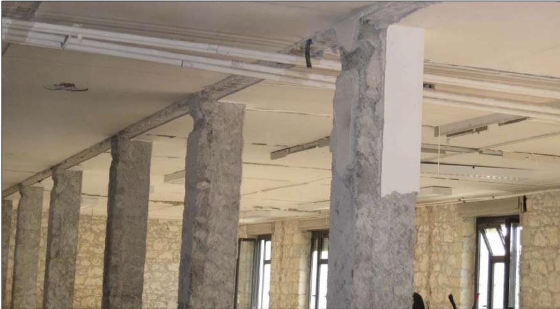
Fig. 03: Pilastrini Piano Terra lato Sud su cui si sono eseguite le prove sclerometriche
