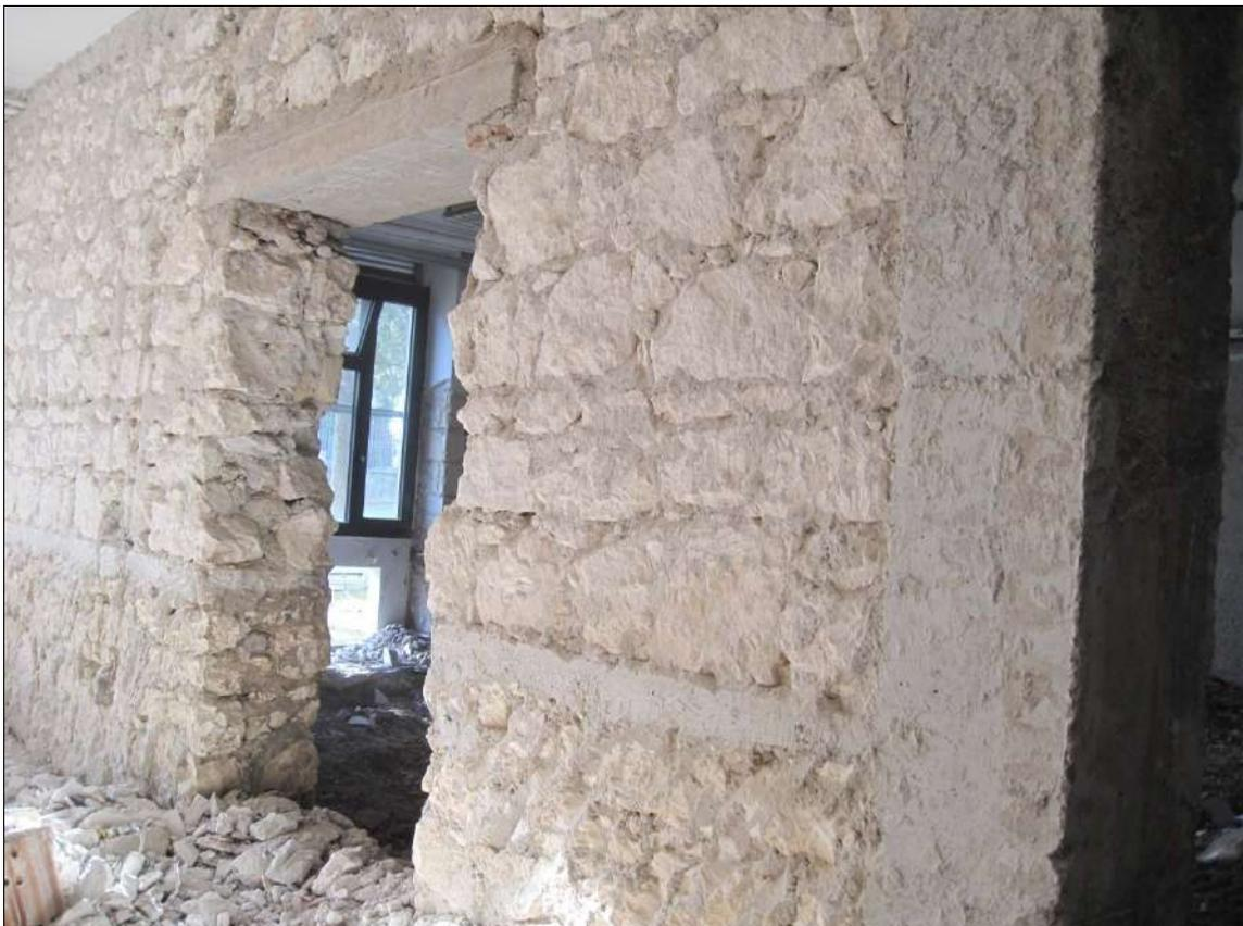
Fig.02: Particolare della muratura priva di intonaco
