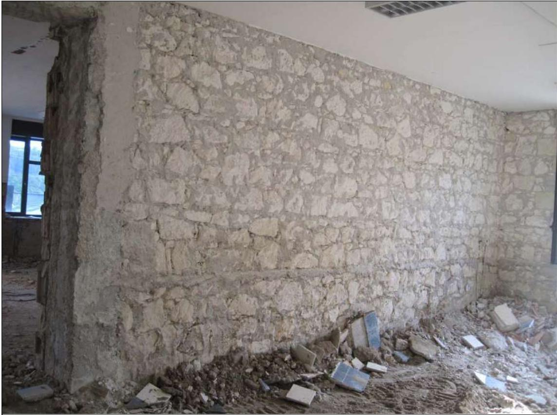
Fig.01: Particolare della muratura priva di intonaco
