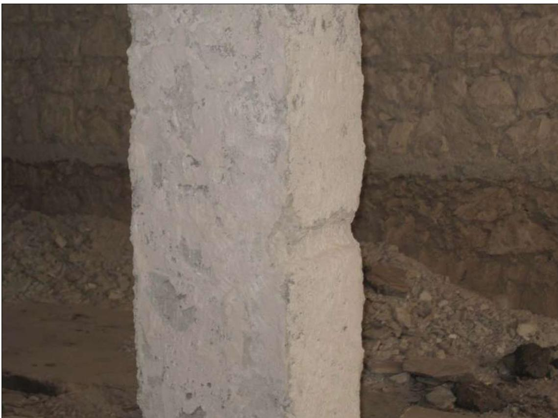
Fig. 04: Particolare pilastro P3 Piano Terra su cui si è eseguita le prove sclerometriche
