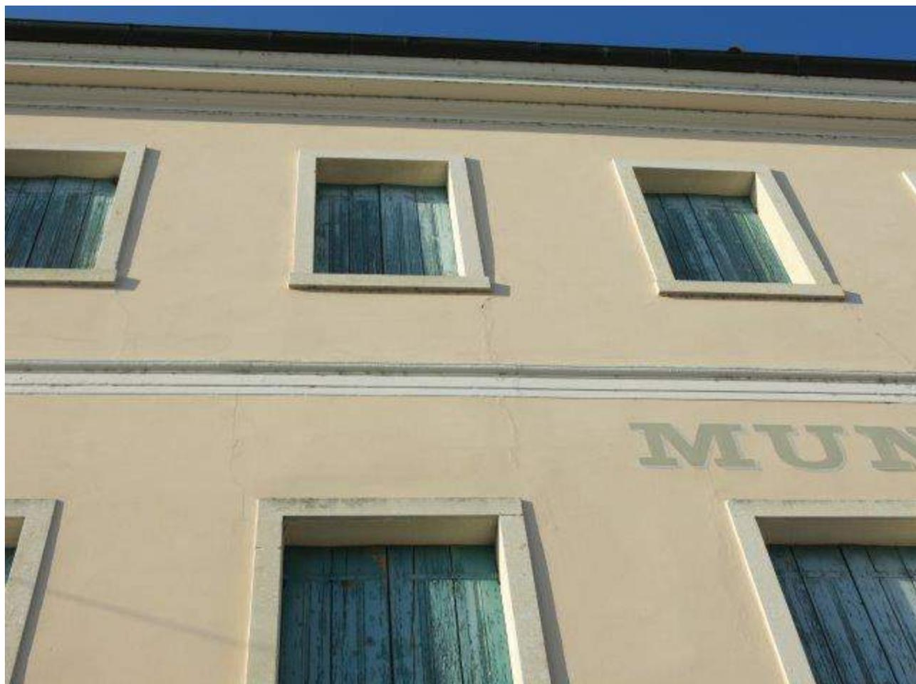
Restauro cornicione e rifacimento degli elementi aggettanti a rilievo, a base di calce fibrorinforzata, perni in fibra di vetro, sagome precedentemente catalogate e autorizzate.
