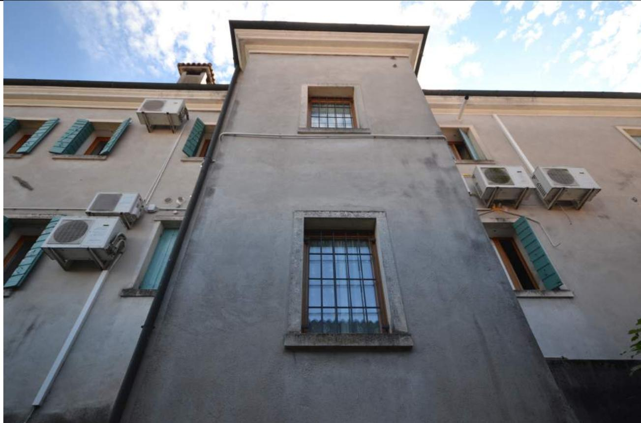
Presenza di una patina biologica costituita da uno strato di depositi polverulenti, muschi e licheni. Ricontrabile in tutte le facciate, in modo particolare nella facciata nord, possiamo notare l'azione di dilavamento e decoesione della finitura nel tempo, presenza di muschi e licheni nei materiali lapidei esposti.
