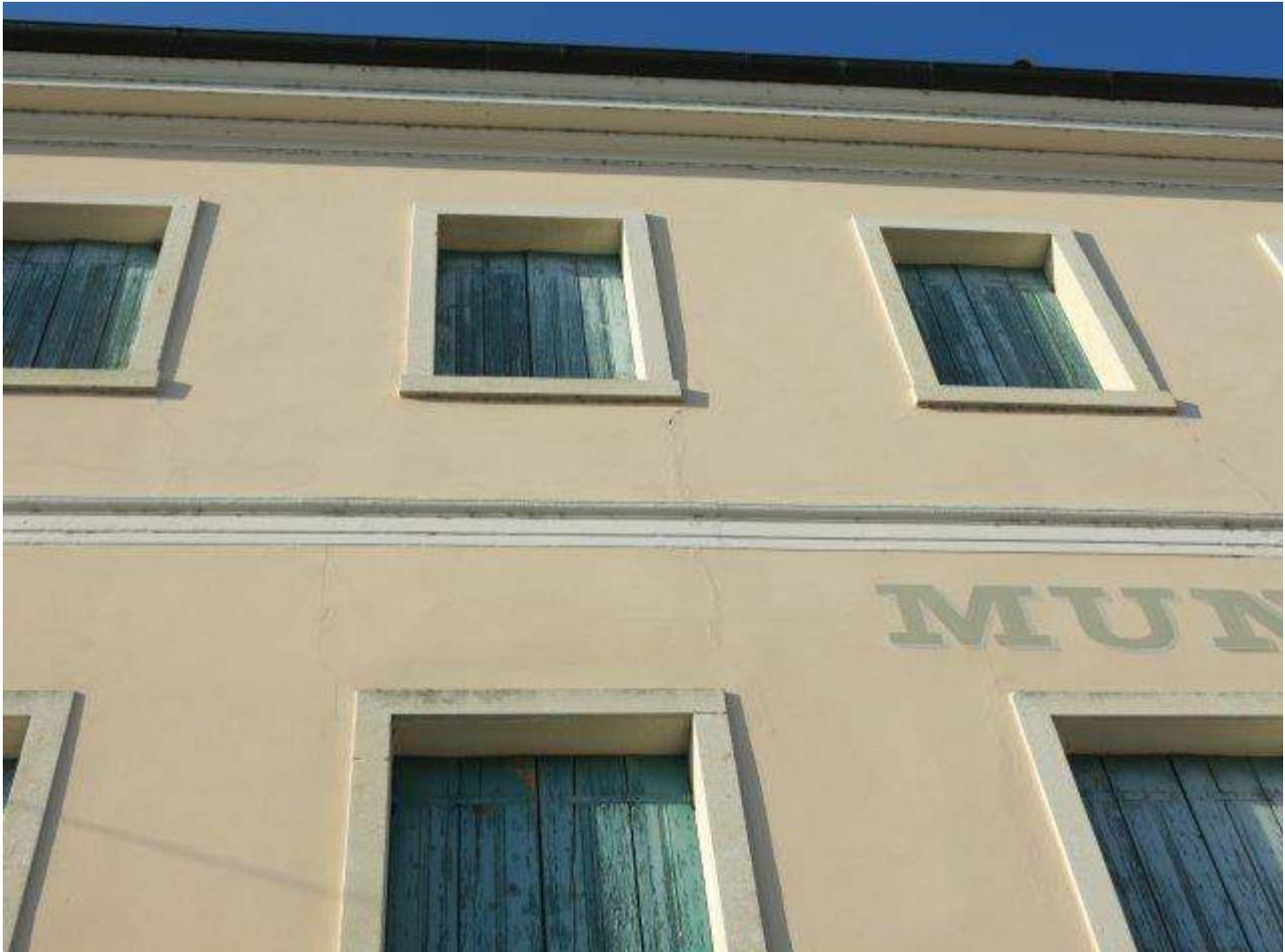
Finitura ad intonaco a base di calce fibrorinforzata abbinato a sistema tipo FRCM o similari eseguito nelle facciate esterne, previa verifica progetto strutturale.
