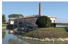
Idrovora di S. Margherita via Idrovora, 7 Codevigo (Pd)
