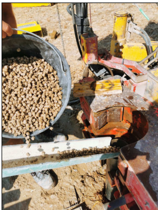
Foto 6: Bentonizzazione del foro di sondaggio S1
