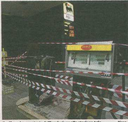
Il self service sventrato dall'esplosione alla stazione Agip Piran
