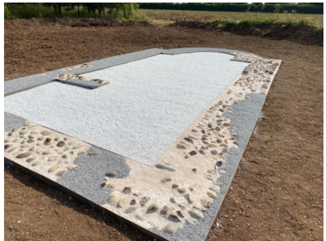
Fig. 4. I lavori di valorizzazione dei resti della chiesa
