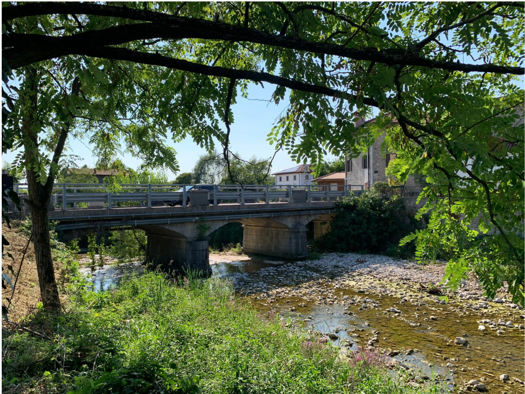
Foto del Ponte di FAEDIS visto da monte verso valle.
