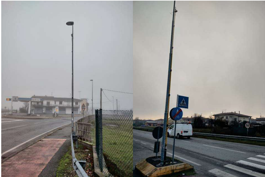
TLC02 – installazione del punto di osservazione A TLC02 – installazione del punto di osservazione B
