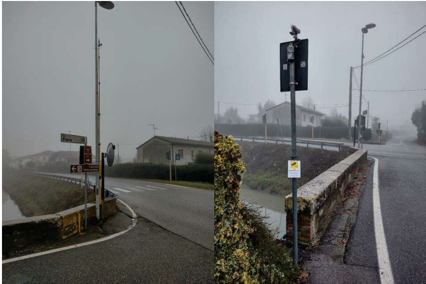
TLC03 – installazione del punto di osservazione A TLC03 – installazione del punto di osservazione B
