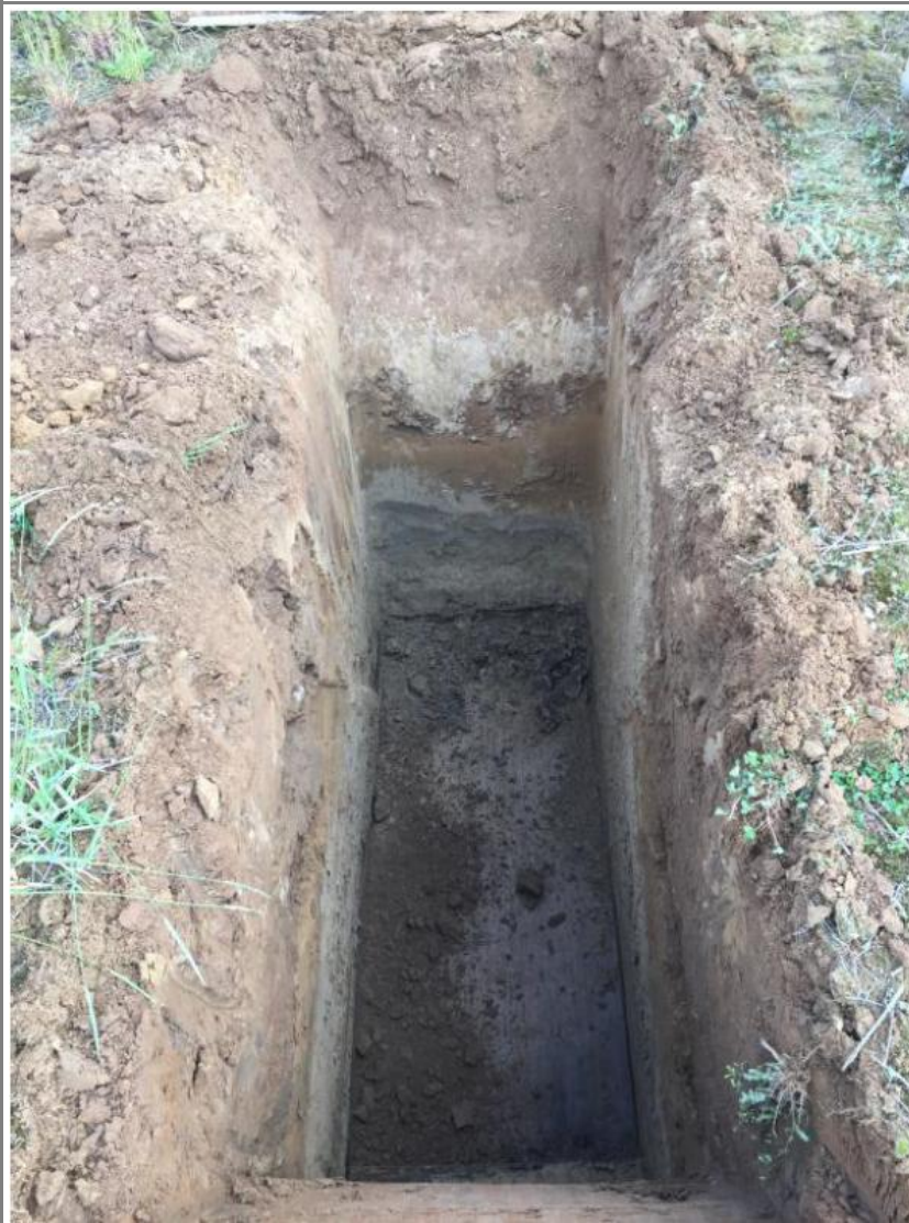
Fig. 17. Particolare di uno scavo eseguito in passato a breve distanza dall'area di studio che permette di prendere visione diretta dei depositi costituiscono il primo sottosuolo locale.
