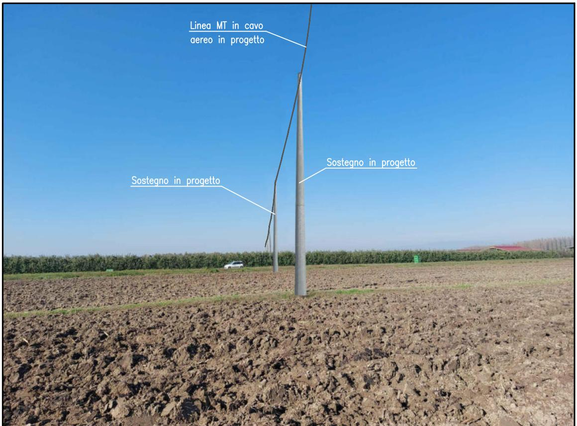
Linea in cavo aereo MT - Palo tipo C in lamiera saldata a sezione ottagonale
