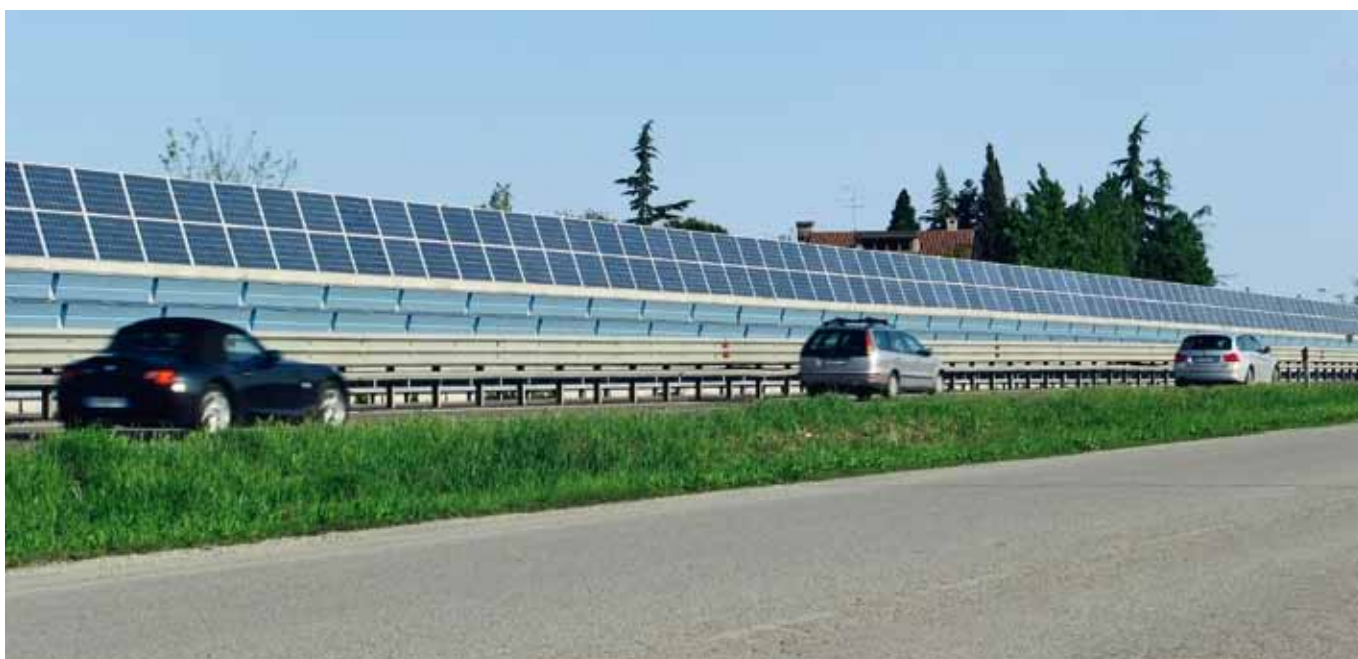
La barriera fotovoltaica di Vallese.
