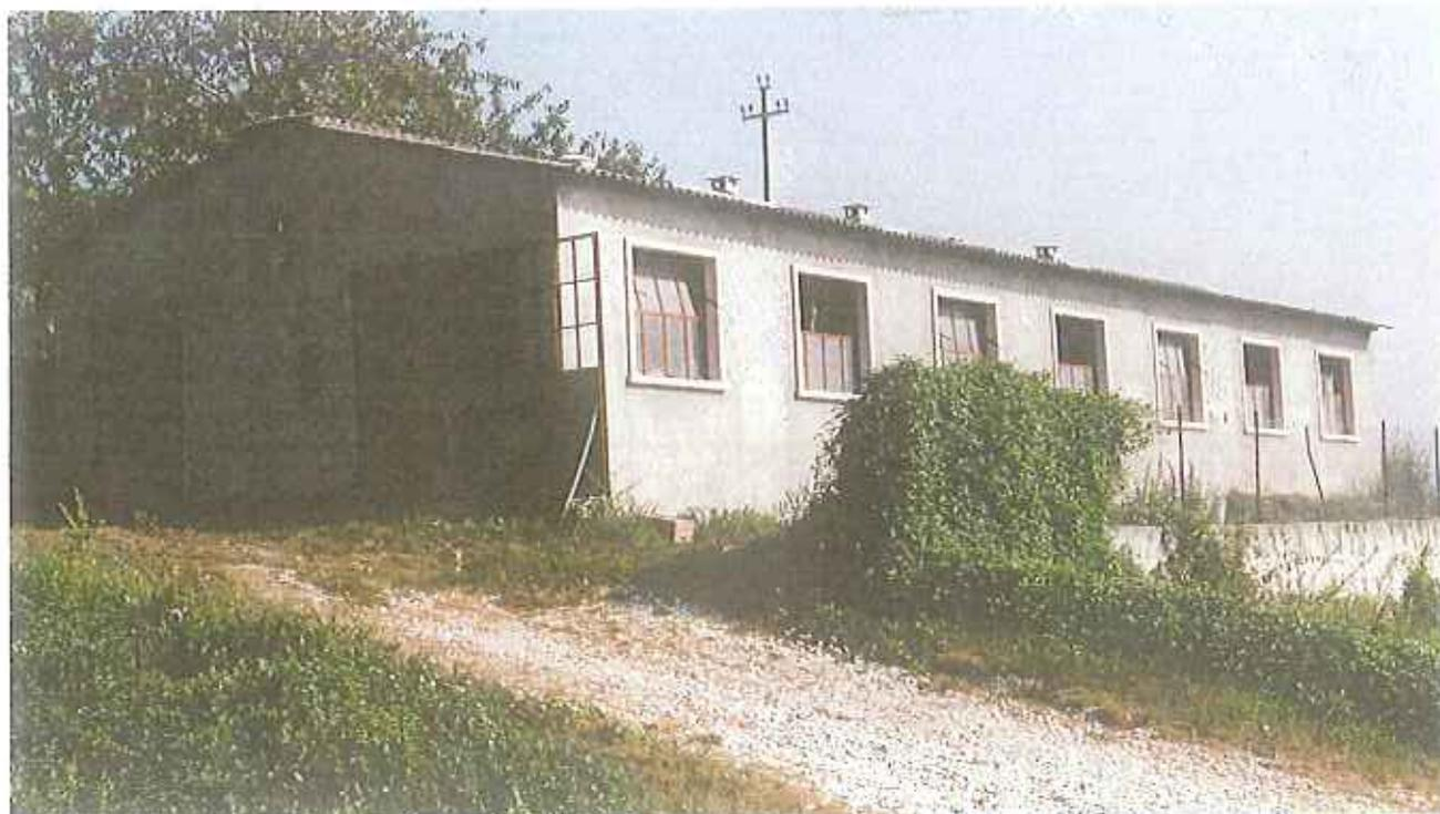
Le facciate devono essere semplici, caratterizzate dalla partizione ritmica degli accessi e delle finestre, ripetuti simmetricamente lungo il lato più lungo del corpo di fabbrica. L'altezza massima in gronda non supera in genere i 4 metri, mentre le pendenze non devono mai essere inferiori al 30 per cento.
