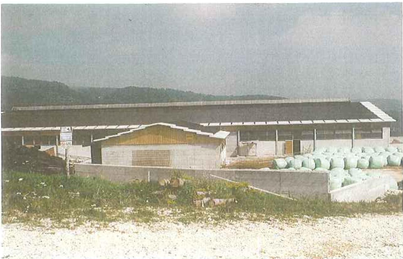
L'edificio sopra riportato unisce una certa cura dei particolari costruttivi (tetto in legno, gronde in pietra locale, tamponamenti in legno) con una scarsa caratterizzazione delle finestrate: tipologia a nastro, assenza di bancali e vetrare derivate dai modelli degli insediamenti industriali. Ne consegue una facciata monotona e complessivamente insignificante.
