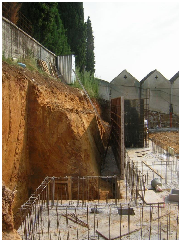
foto 3 – Fronte di scavo per la realizzazione dell'ampliamento del cimitero di Sarcedo.
