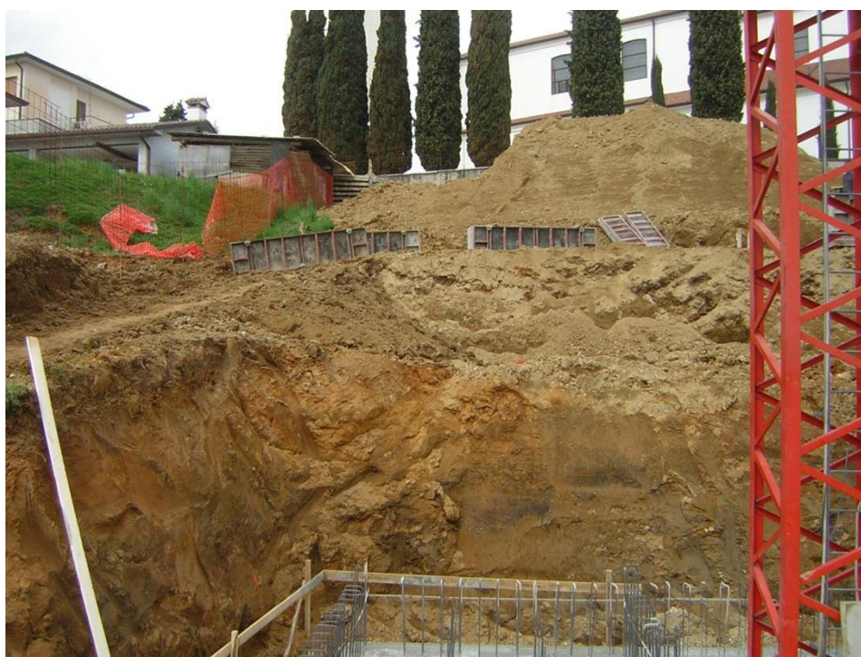
foto 4 – Fronte di scavo per la realizzazione dell'ampliamento del cimitero di Sarcedo. (le foto n° 3 e 4 sono originali, scattate durante l'esecuzione della propria attività professionale – R_005/008)
