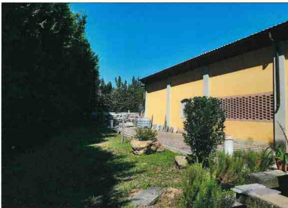
Vista del capannone (lato ovest) con la quinta vegetativa di mitigazione
