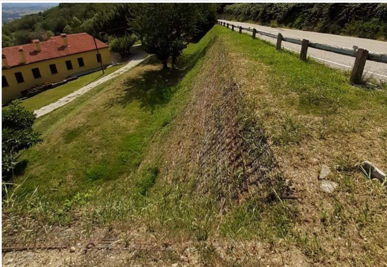
*Foto dello scrivente agosto 2020, terre armate a sostegno del versante prospiciente l'abitazione a valle di via Spiasi.*
