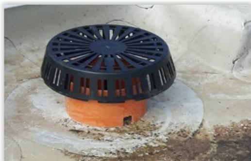
Tale dispositivo di controllo va a garantire un coefficiente udometrico inferiore a 10 l/sha con protezione del foro da foglie con ghiaia e un troppopieno sempre protetto
