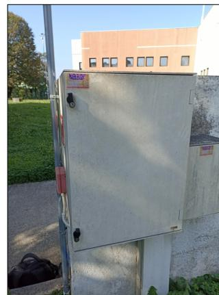
Quadro elettrico già esistente nell'area (da mantenersi come allo stato attuale), contenente al suo interno anche i dispositivi di protezione / comando del circuito di illuminazione pubblica oggetto di interventi
